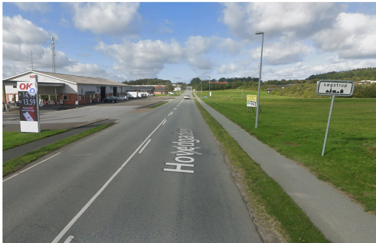
FIGUR 14: STRÆKNING AF HOVEDGADEN, HVOR DER ØNSKES FARTDÆMPENDE TILTAG.
